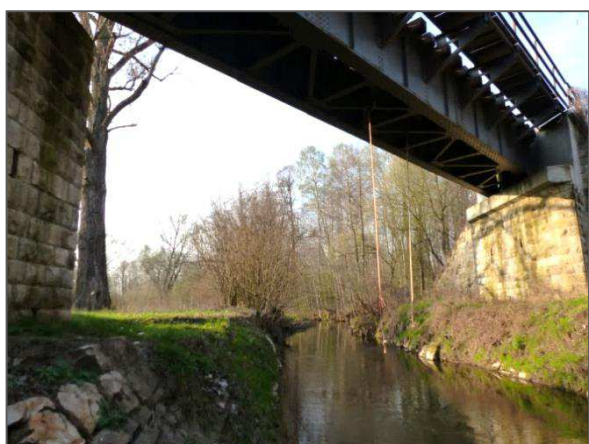
Obr. 3 a 4: Most v km 103,962 je migračně dobře průchodný pro savce, obojživelníky i plazy, neboť po obou stranách toku je zachován dostatečně široký pás suchého břehu s přírodním povrchem.
