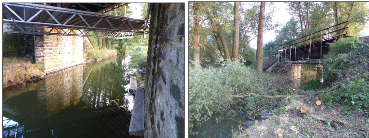
Obr. 7 a 8: Most v km 108,576. Z hlediska migrační prostupnosti se jedná o nevhodné řešení, neboť voda pod mostem zasahuje až k pilířům mostu a neumožňuje suchý průchod. Řešením může být buď dobudování bermy, případně obnova někdejší lávky.
